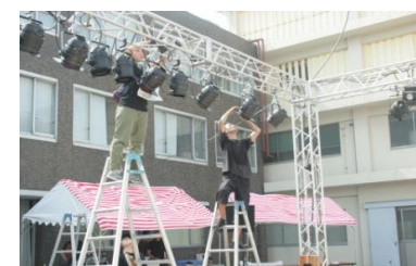
立体トラスで照明機材をセッティング。
